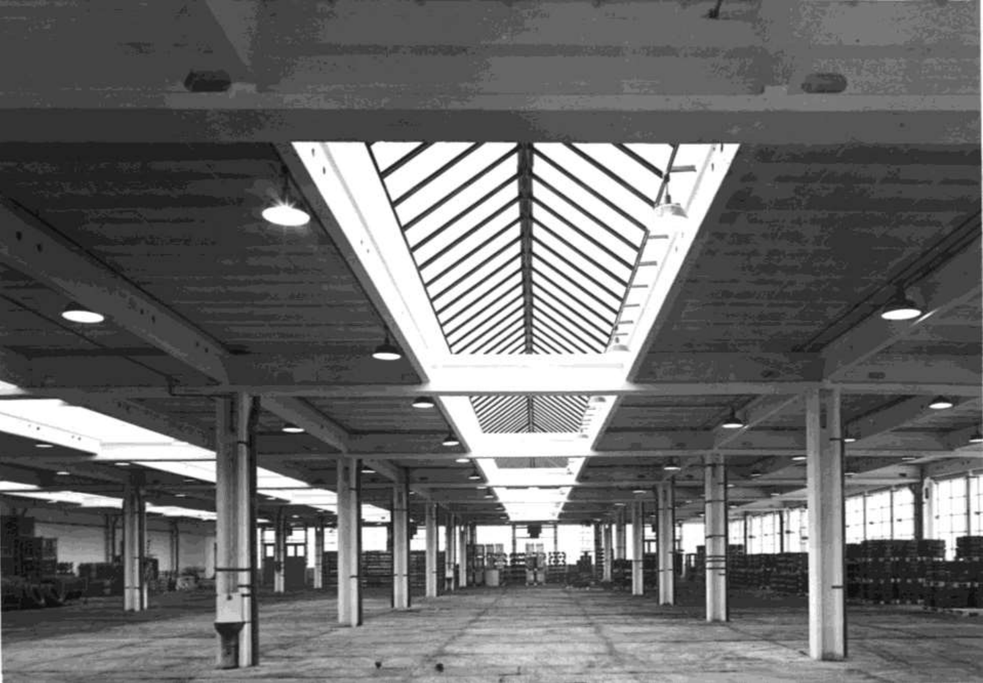
Hétköznapi feladatok: üzemi előregyártás: 9x9 m-es típus vázszerkezet, IPARTERV, 1965, Bajnay László és Gnädig Miklós Dobai János DLA egyetemi docens, tanszékvezető, Ipari és Mezőgazdasági Épülettervezés Tanszék
