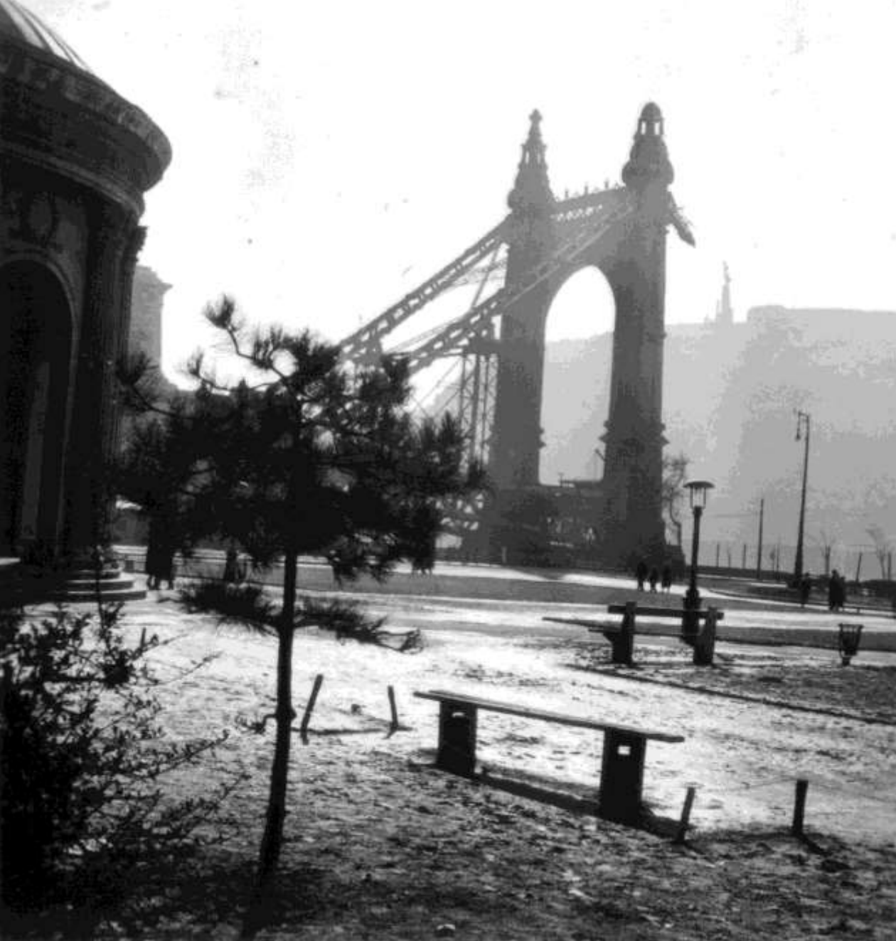
A felrobbantott Erzsébet híd a Vigadó tér felől nézve 1946
