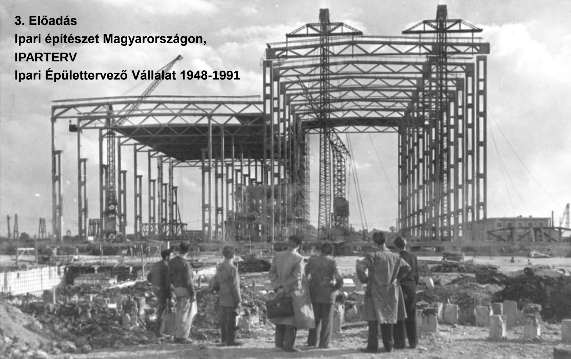
Tiszapalkonyai Hőerőmű, főtartó emelése művezetés , 1953, IPARTERV, Mátrai Gyula, Pásztai Károly
