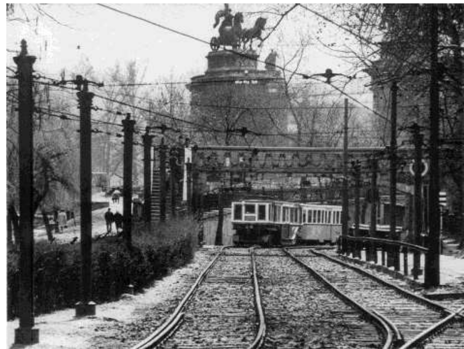
(Milleneumi, M1) Földalatti 1896! (vasbeton híd: Wüncz Róbert)
