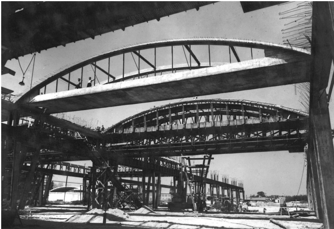
5. kép. Székesfehérvár, Könnyűfémmű Alumínium öntöde és présmű építése. Az íves tartók (és az alsó övökre épített síklemez építése a darupályára épített zsaluzaton. MIEA 3851
