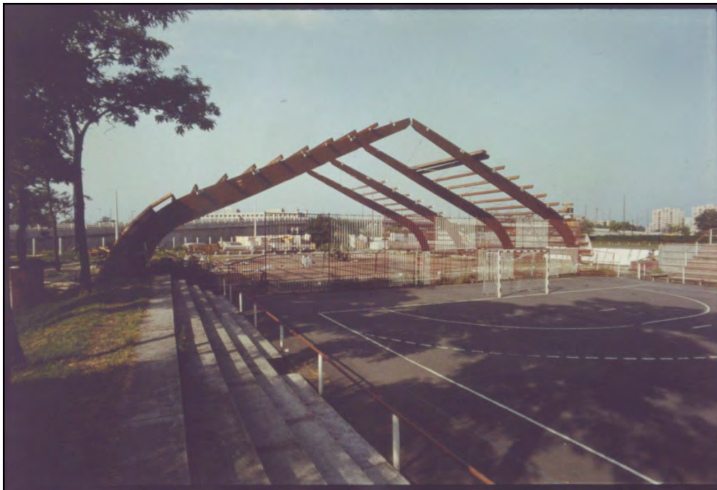
26. kép. Spartacus Teniszcsarnok, Budapest X. Kőér utca. Építész: Sylvester Ádám, statikus: Steinhausz Tibor. Építés közben. Jól látható a háromcsuklós keretes szerkezet. MIEA 22601_0002_0011
