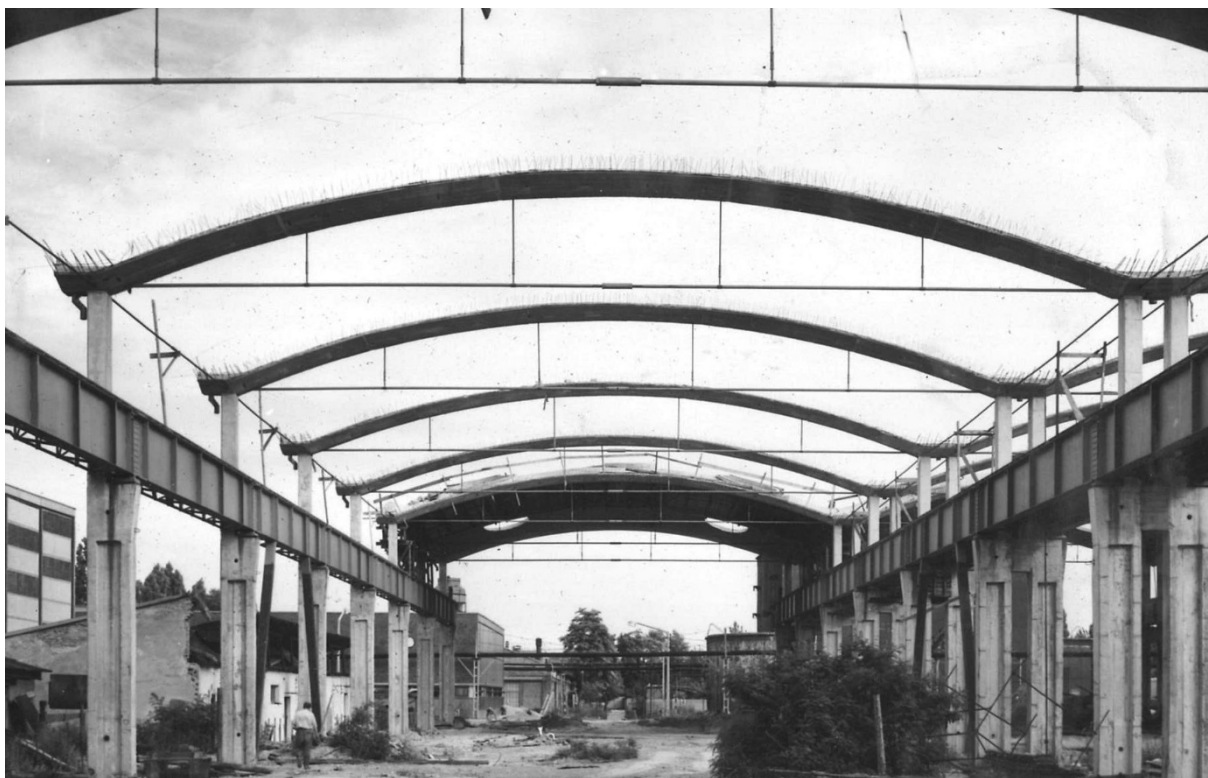
15. kép. Csepel, Csepel Vas- és Fémművek, Szerszámgépgyár építése. Reisch Róbert (építész: Pál Balázs) 1967. Jól látható, hogy a korábban megépült megoldásokhoz képest mennyivel egyszerűbb a szerkezet. Az Y pillérek és a dupla íves gerendák helyett szimpla négyzetes keresztmetszetű pillérek, szimpla vonóvasas ív a kiinduló szerkezet. MIEA 8821
