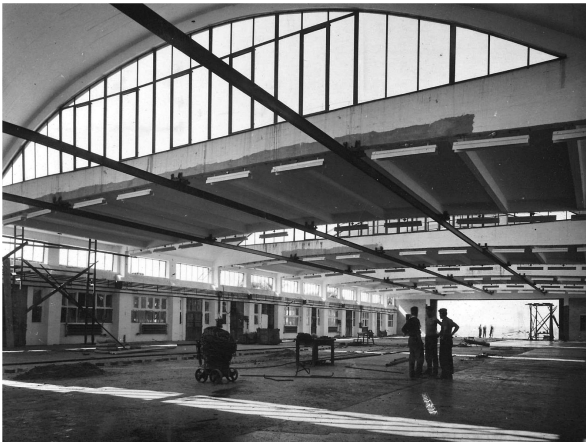
24. kép. Esztergom. Sportszergyár. (PG esztergomi részlege). Gnädig Miklós, építész: Sillye Zoltán, 1960-as évek eleje. Itt az előzőkénél egyszerűbb módon jött létre hasonló belső tér. A pillérmezők váltakozva síklemez és donga lefedésűek. A váltakozás lehetővé teszi a függőleges síkú felülvilágítók megépítését. MIEA 6719
