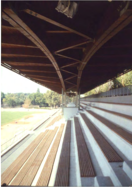
23. kép. Úttörőstadion. A szerkezet részlete. MIEA 22603_2_0003
