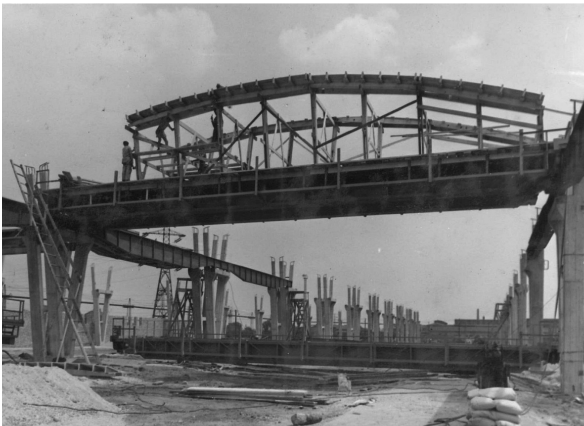
10. kép. Csepel, Csepel Vas- és Fémművek, Csőgyár üzemi csarnok építése. Menyhárd István, Semsey Lajos, Reisch Róbert 1961. Hasonlóan a székesfehérvári előzményhez, itt is (az Y pillérekre állított) darupálya készül először, majd az erre szerelt mozgó zsaluzaton épülnek meg az kiváltó ív-párok.
